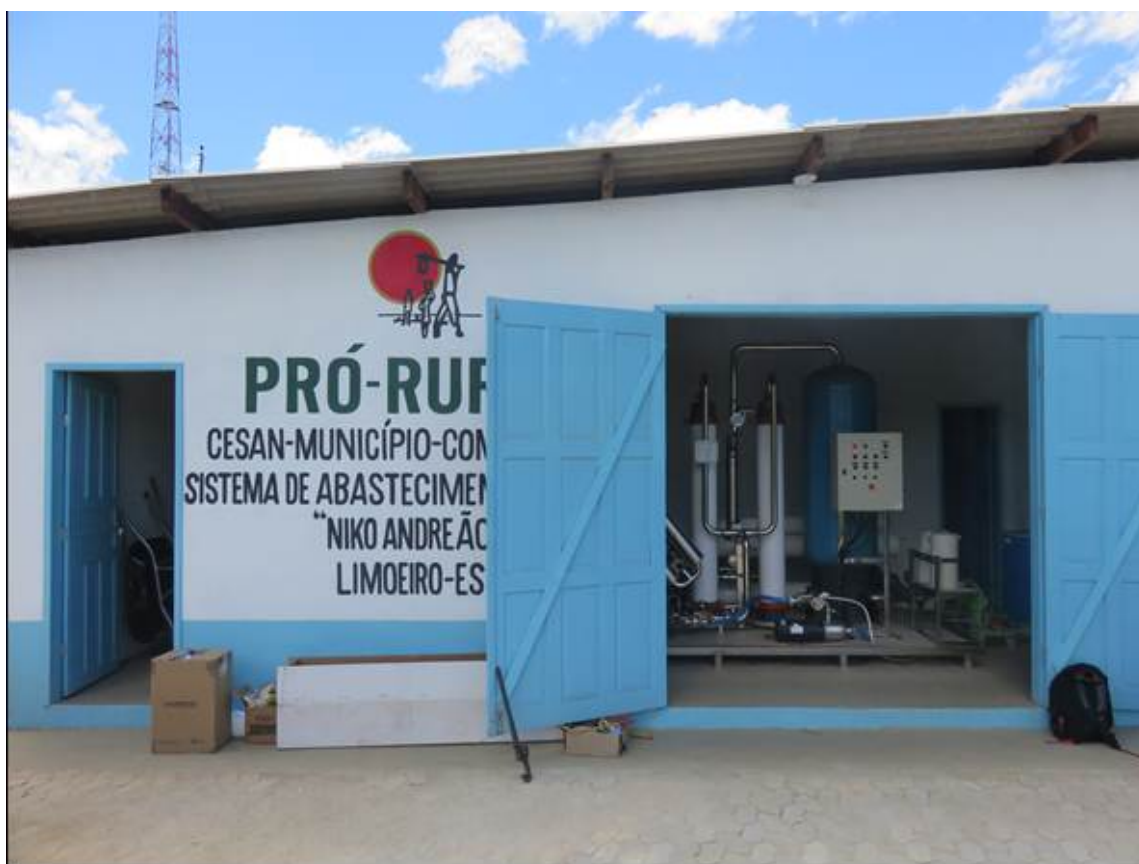
Figura 1: Configuração da ETA compacta Limoeiro – Castelo/ES
